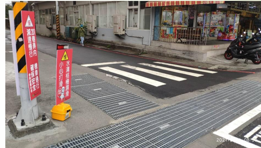
201巷口前排水 溝鐵柵，下雨 天很滑
