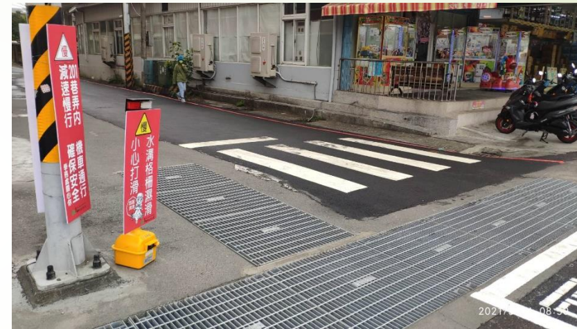
201巷口前排水溝鐵柵，下雨天很滑
